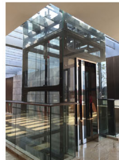
最小顶层高度 2.8 米 Minimum headroom height of 2.8 m
